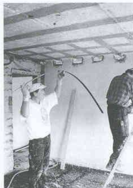
8 Montage von CFK-Lamellen
