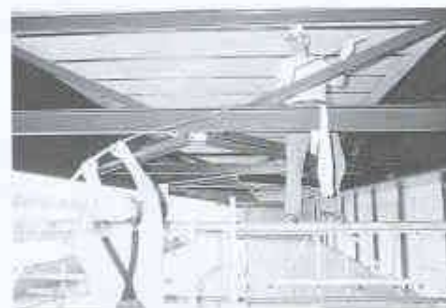
5 Applikation CFK-Lamelle
