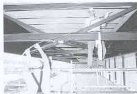
5 Applikation CFK-Lamelle
