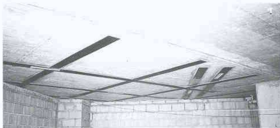
4 Verstärkte Stahlbetondecke mit dreifacher Lamellenkreuzung
