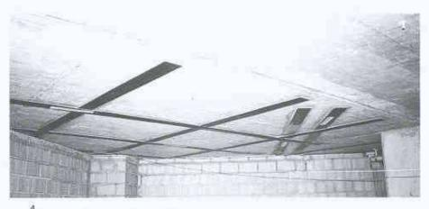
Verstärkte Stahlbetondecke mit dreifacher Lamellenkreuzung
