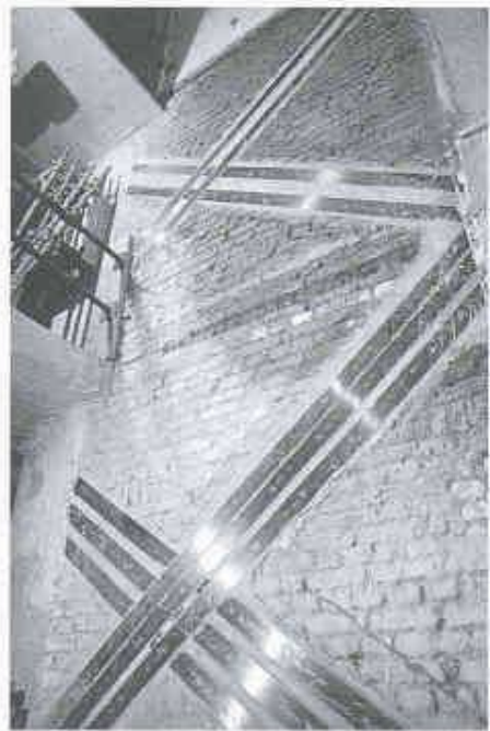
5 Anordnung der CFK-Lamellen auf der Mauerwerktragwand
