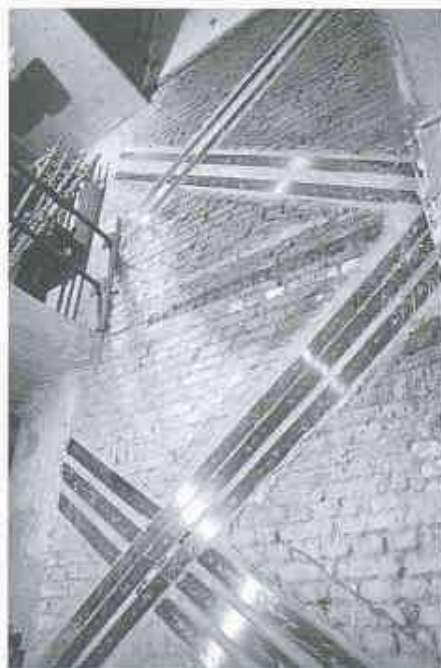
Anordnung der CFK-Lamellen auf der Mauerwerktragwand
