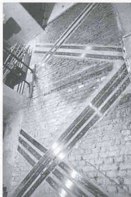
Anordnung der CFK-Lamellen auf der Mauerwerkstragwand
