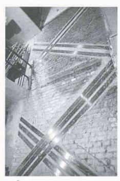
Anordnung der CFK-Lamellen auf der Mauerwerktragwand
