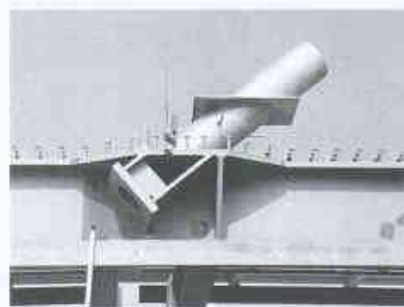
4 Spannkabel: Verankerungsdetail
