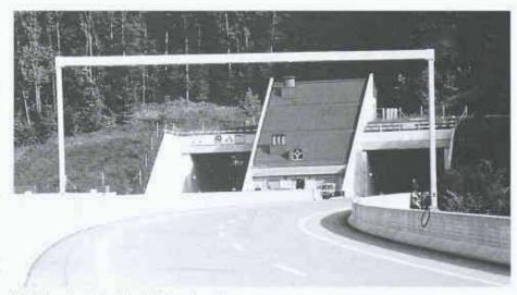
Betriebszentrale Nord des Habsburgtunnels zwischen den beiden Tunnelröhren. Das Dach übernimmt die Hangneigung
