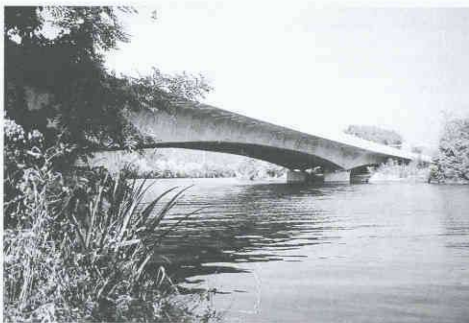
Die Aaretalbrücke quert, nur wenig über dem Gelände, mit schön geschwungenem Vouten-
