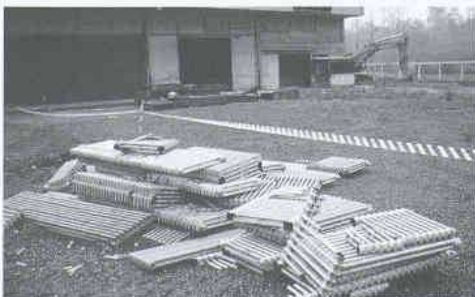
Rückbau statt Abbruch, Suglio 1992 (Bilder: Giosanna Crivelli, Montagnola)
