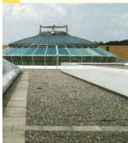
Umbau Einkaufszentrum Glatt. Mit Sarnafil T.
