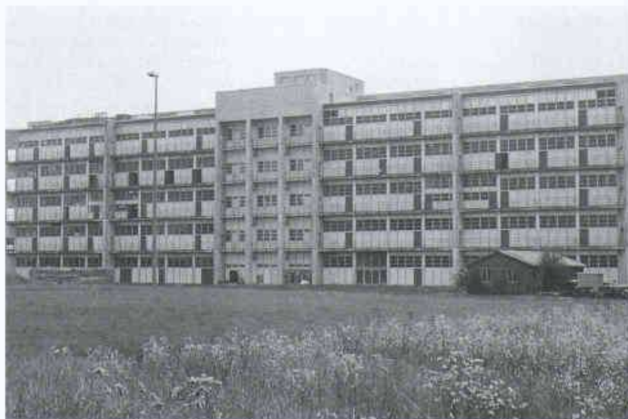
5 Produktionsgebäude der chemischen Industrie mit einer als Druckentlastung ausgebildeten Fassadenkonstruktion
