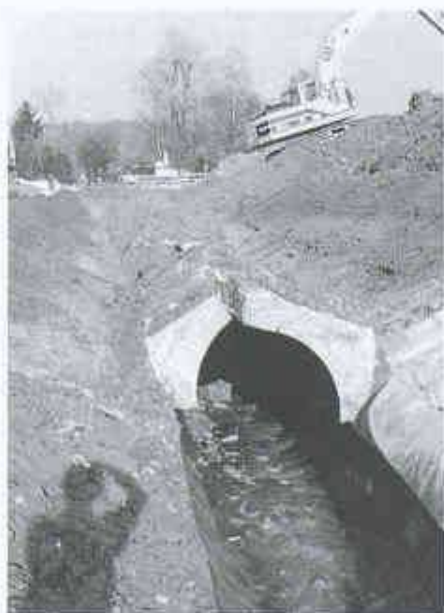
2 Durch Explosionswirkungen erheblich beschädigter Zulaufkanal, durch Bagger freigelegt
