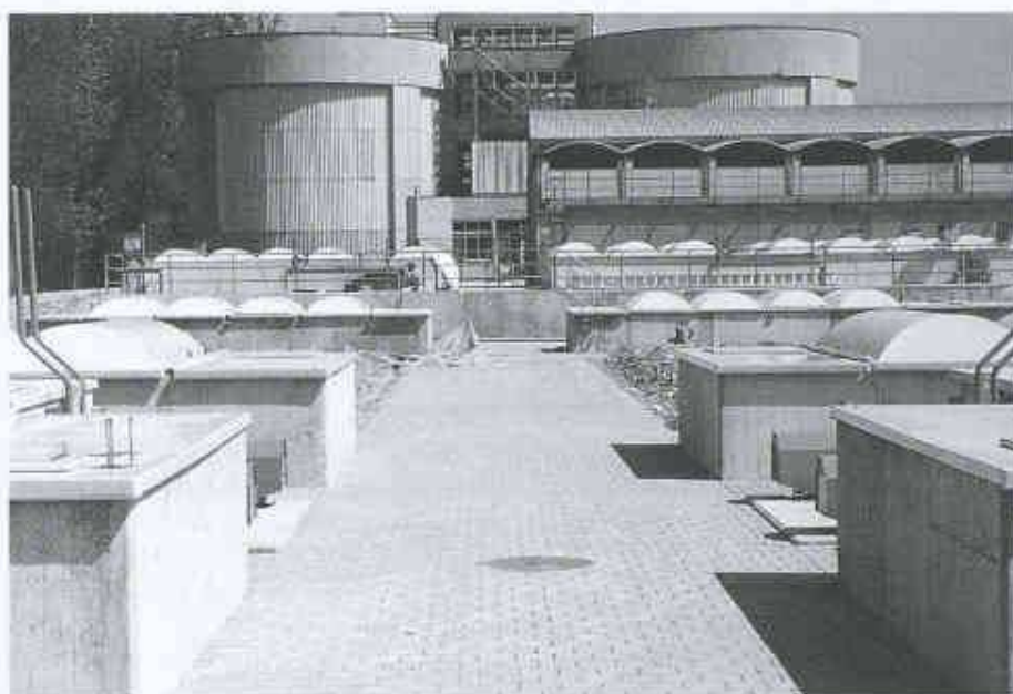
4 Abdeckungen der Druckentlastungsöffnungen grossvolumiger unterirdischer Klärbecken einer
