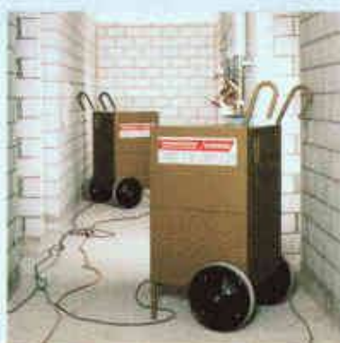
Bauaustrocknung
