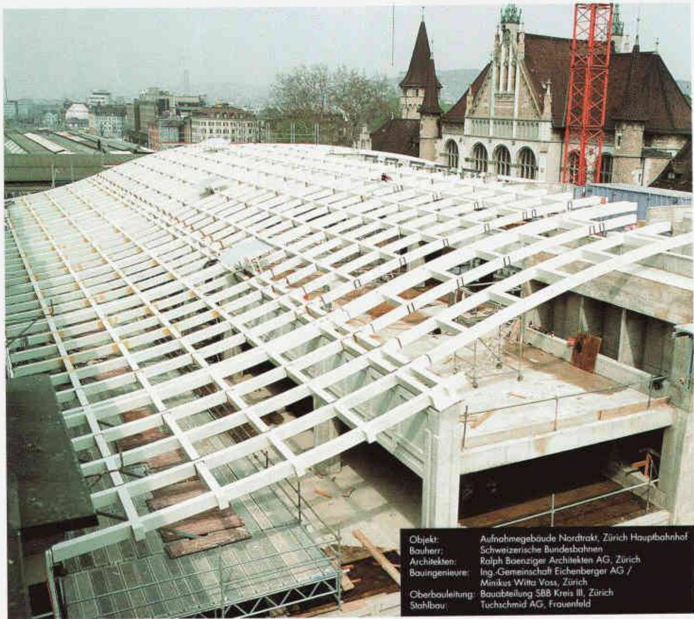
Architekten und Ingenieure schätzen die Form und die Wirtschaftlichkeit. Es gibt weitere Gründe, die für RHS-Profile sprechen. Zum Beispiel das homogene Materialgefüge über den ganzen Profilquerschnitt.
