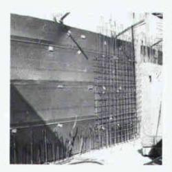
Filter- und Sickerschicht, keine Baugrubenverfüllung!
