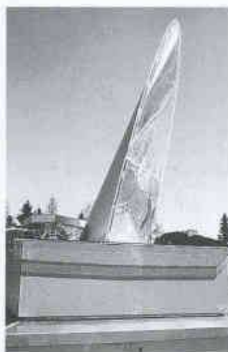
Pilotanlage in St. Gallen: Der Heliobus leitet Tageslicht in dunkle Räume
