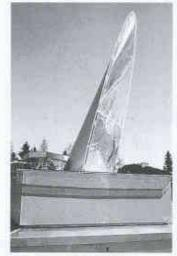
Pilotanlage in St. Gallen: Der Heliobus leitet Tageslicht in dunkle Räume
