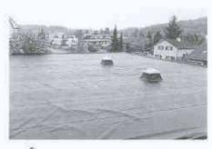
Die Verleger verlangen von der Zulieferindustrie Dachsysteme, die die Arbeit auf der Baustelle vereinfachen und somit technisch weniger anfällige Flachdachkonstruktionen zu einem günstigen Preis ermöglichen. Oben: Verlegen der vorkonfektionierten Abdichtung, unten: montierte Abdichtung
