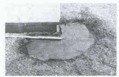
16 Gerichtete Risse in Deckbitumen infolge Spannungen in der Abdichtung
