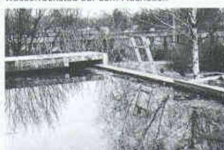
20 Wasserrückstau auf dem Flachdach
