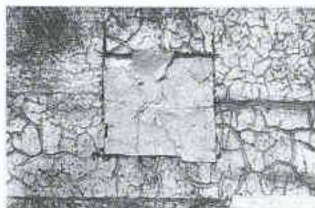
13 Risse in Deckbitumen zerstören Träger
