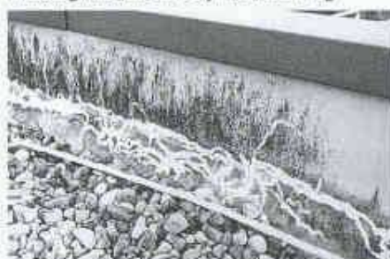
17 Mikroorganismen auf Polymerabdichtung
