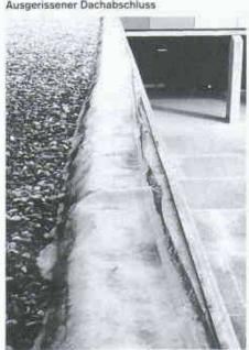
serrückstau ein Schaden entsteht, ist relativ gross, besonders wenn für die Abschlüsse Winkelbleche eingesetzt wurden. Ein geschickt plazierter Notüberlauf macht auf verstopfte Abläufe aufmerksam und ist in jedem Fall empfehlenswert.
