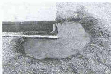
16 Gerichtete Risse in Deckbitumen infolge Spannungen in der Abdichtung
