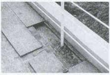
werden. Von Humus überdeckte Abschlüsse werden mit Sicherheit undicht, da sie nicht rückstausicher sind und die Kittfugen nicht unterhalten werden können.
