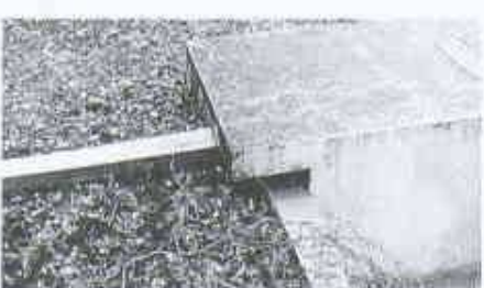
25 Verunmöglichter Unterhalt des Dachrands
