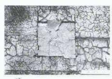
13 Risse in Deckbitumen zerstören Träger
