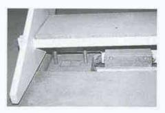
Aufnahme der vertikalen und horizontalen Kräfte durch zwei in den Achsen zueinander verdreht angeordnete Zug-Druck-Elemente, Oben: am Treppenfuss, unten: am Mittelpodest
