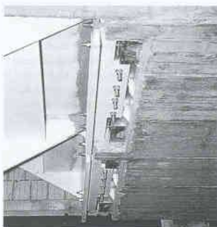
4 Aufnahme der vertikalen und horizontalen Kräfte durch zwei in den Achsen zueinander verdreht angeordnete Zug-Druck-Elemente. Oben: am Treppenflus, unten: am Mittelpodest
