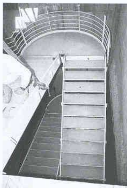
2 Montage der frei auskragenden, gut ausgesteiften Stahltreppe
