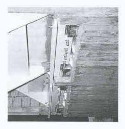
Stahltreppenauflager und Befestigungen mit vorgespannten Zug-Druck-Elementen, wie in (2) gezeigt, bringen, bedingt durch ihre Feder-, und Dämpfungseigenschaften, eine praktische Trittschallreduktion zwischen 12 und 18 dB. Unter Berücksichtigung der Treppenmasse und der Treppenaussteifung kann eine zusätzliche Dämpfung der Schallausbreitung durch konstruktive Massnahmen erzielt werden.
