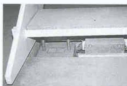
4 Aufnahme der vertikalen und horizontalen Kräfte durch zwei in den Achsen zueinander verdreht angeordnete Zug-Druck-Elemente. Oben: am Treppenflus, unten: am Mittelpodest
