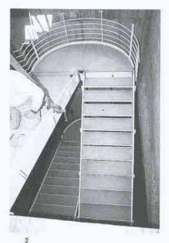
Montage der frei auskragenden, gut ausgesteilten Stahltreppe
