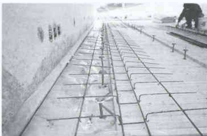
1 Brettstapeldecke mit Kerbe und Verbund- anker
