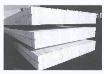
Brettstapelelemente werden vorgefertigt auf die Baustelle gebracht
