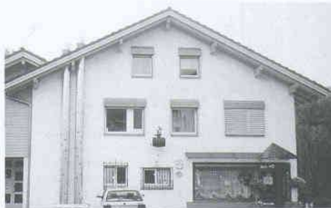
5 Wohnhaus und Restaurant Seehus in Hergiswil am Vierwaldstättersee: Die Stiftung für besondere Leistungen im Umweltschutz zeichnete den ökologisch ausgerichteten Um- und Anbau mit dem Preis 1996 aus. In der Mitte der Fassade: Rohre der Wärmerückgewinnungsanlage (Bild: T. Glatthard)
