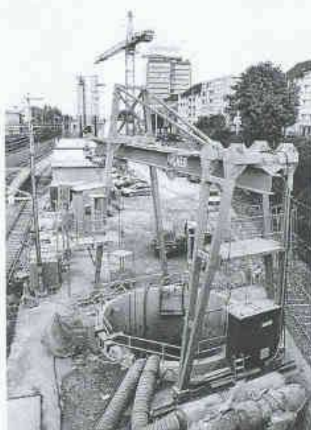
Einrichtung des Installationsplatzes am Bahnhof Oerlikon. Im Vordergrund der Vertikalschacht (Bild: Comet)
