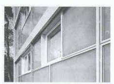
Die TWD-Platten wirken als Isolation und lassen dabei das Sonnenlicht durch. Sie sind direkt auf der Aussenwand montiert
