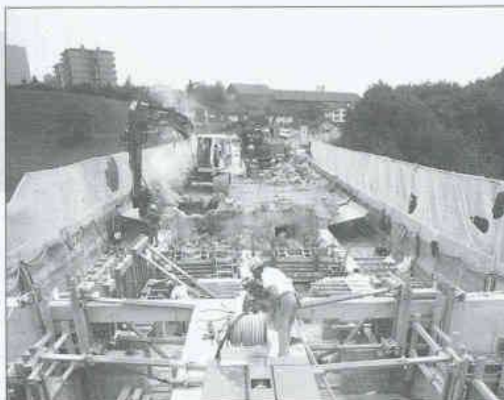
Sanierung und Verbreiterung der Pérolles-Brücke, Freiburg
