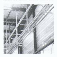
fangreichen Zubehörsortiment. Es eignet sich als Montagesystem in der Sanitär-, Heizungs-, Lüftungs- und Elektrobranche und ist das einzige System auf dem Markt, das über alle erforderlichen Trag- und Befestigungskomponenten verfügt, die koordinierte Haustechnik- oder Gesamtinstallationen benötigen.
