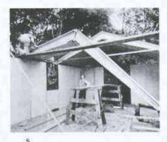
Fertighäuser mit Faltdach in Sperrholz um 1942. Diese Fertighäuser standen bei der U.S. Army im Kriegseinsatz und dienten als Lezarette, Mannschaftsunterkünfte und Materiallager
