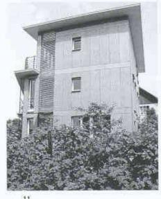
Bürchaus Markwalder in Brüttisellen. Die Sperrholzplatten wurden zu kleinen Formaten zugesägt. Sie dienen als Fassadenschmuck, die eigentliche Schutzfunktion übernimmt die darunterliegende Wetterhaut
