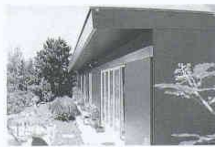
12 Anbau an ein Einfamilienhaus in Unterengstringen von Rudolf Moser. Das Haus ist in kräftigem Rot gestrichen
