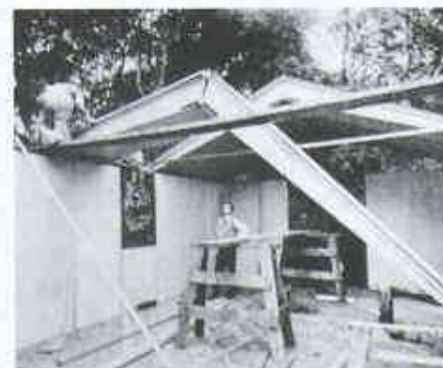
5 Fertighäuser mit Faltdach in Sperrholz um 1942. Diese Fertighäuser standen bei der U.S. Army im Kriegseinsatz und dienten als Lazarette, Mannschaftsunterkünfte und Materiallager
