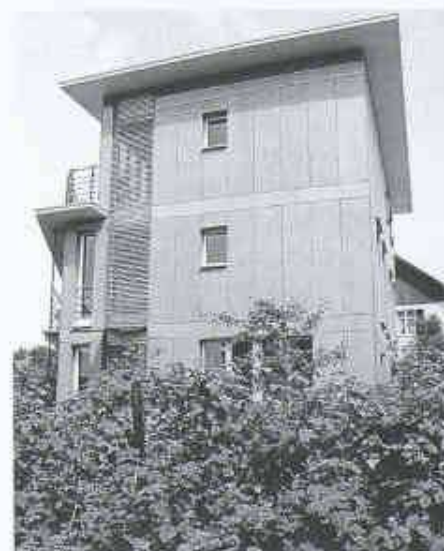
11 Bürohaus Markwalder in Brüttsellen. Die Sperrholzplatten wurden zu kleinen Formaten zugesägt. Sie dienen als Fassadenschmuck, die eigentliche Schutzfunktion übernimmt die darunterliegende Wetterhaut.
