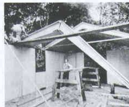
5 Fertighäuser mit Faltdach in Sperrholz um 1942. Diese Fertighäuser standen bei der U.S. Army im Kriegseinsatz und dienten als Lazarette, Mannschaftsunterkünfte und Materiallager
