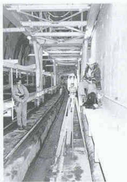
3 Vereina Nord, Kontrollpunkt im Bereich des Nachläufers
