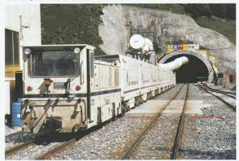
Der auf der Anlage hergestellte Nassspritzbeton für Vortriebssicherung und Tunnelausbau wird mit speziellen Nachmischwagen in den Tunnel eingefahren. Eine in der Nähe der Betonanlage angeordnete Wagenwaschanlage mit Grobabsetzbecken und Wasserrezirkulation gewährleistet eine einwandfreie Rollmaterialreinigung.
