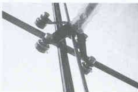
Geschäftshaus Hanauer Landstrasse, Frankfurt a. Main/D, Architekten: Schneider+Schumacher, Frankfurt a. Main/D, Detail einer punktförmig geschraubten Glasbefestigung
