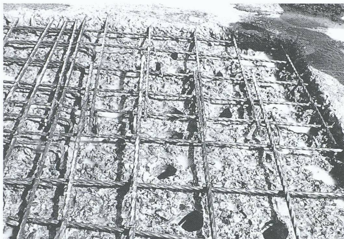
Betonabtrag von 80 mm mittels Hochdruckwasserstrahlen an der Europabrücke in Zürich
