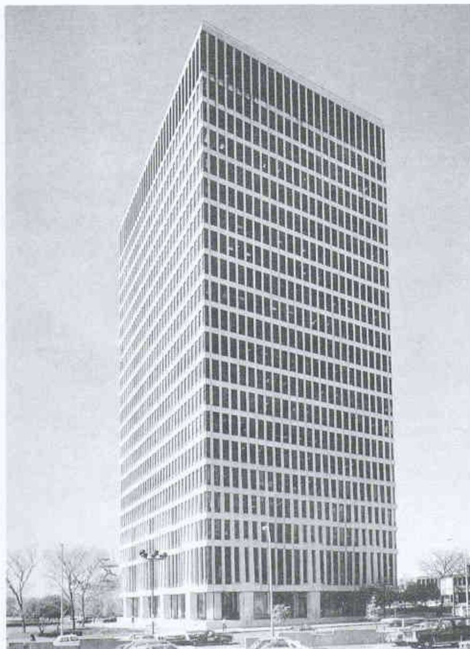
5 Marine Midland Bank Building, Rochester (NY), 1968 (Bild: David P. Billington; Robert Maillart, Birkhäuser Verlag AG, Basel)
