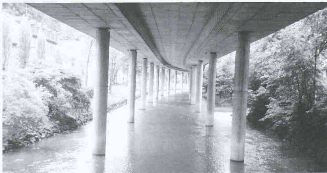
1 Nationalstrasse N3 in Zürich, Brückenuntersicht
