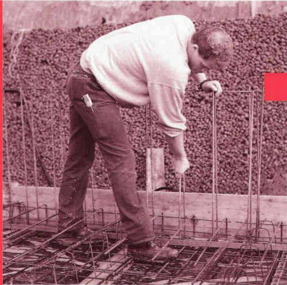
Wenn das Praktische, das Angenehme und das Wirtschaftliche so eng verschweißt sind, kann es sich nur um den FIRIPA-Anschlusskorb handeln. Im Handumdrehen massgenau und sicher - von einer Person - versetzt, erspart er das mühsame Aufstellen einzelner U-Bügel, das zeitraubende Fixieren an Längsstäben und das nervensägende Umkippen. Über die weiteren Vorteile brauchen wir uns nicht zu unterhalten. Die liegen ja buchstäblich auf der Hand. Die FIRIPA-Anschlusskorbe finden Sie im Fachhandel.
