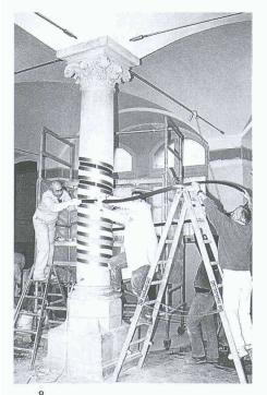
Schräger Einschluss in Natursteinsäule und spiralförmig aufgezogene CFK-Lamelle; Foto: Ausführung
