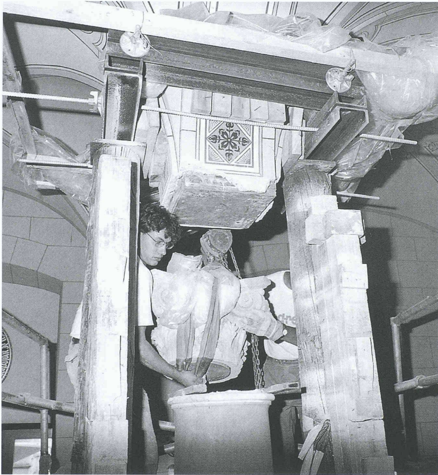
Wiedereinbau eines Natursteinkapitells, das durch einen Stahlkern verstärkt wurde
