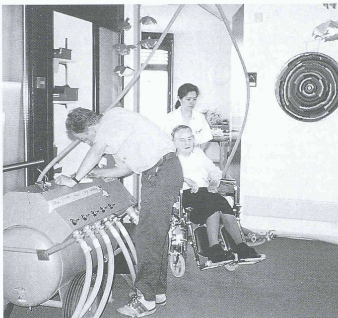
Die Rohrsanierung im Pflegeheim störte kaum den normalen Betrieb
