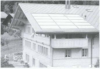
Zur Aufbereitung des Warmwassers und zur Heizungsunterstützung integrierte Schweizer bei diesem Hasliberger Mehrfamilienhaus 39 m<sup>2</sup> Sonnenkollektoren nahtlos ins Eternitdach
