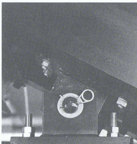
2a und b Kanalaufleger a) oberes drehbares Bolzenauflager und b) einseitig demontierbare Stütze mit Rohraufleger
