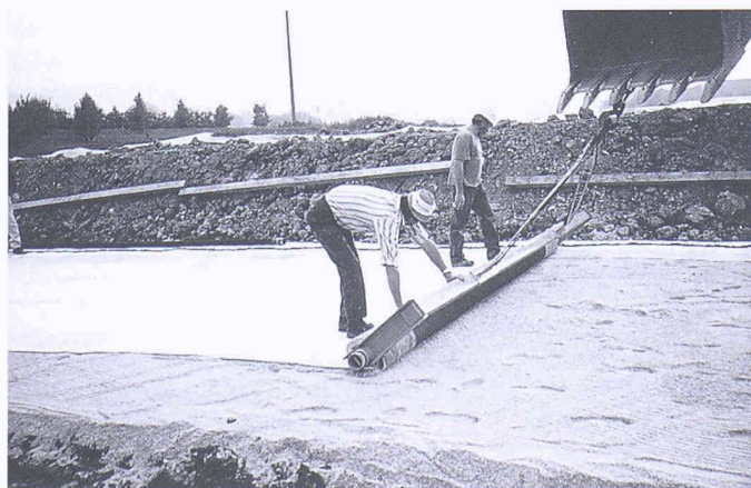
Verlegung der Dichtungsmatte Bentofix® D 4000 direkt auf der Gasdränage aus Glassand
