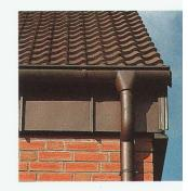
TECU®-Oxid Dachentwässerung voroxidiert, gleichmäßig braun.
