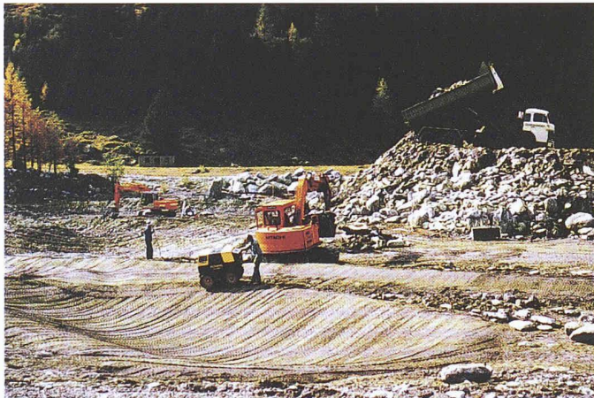
Bau der Weiher in der Ebene von Bonatchiesse. Beachtenswert ist der enorme Kies- bzw. Blockanteil des Baugrundes
