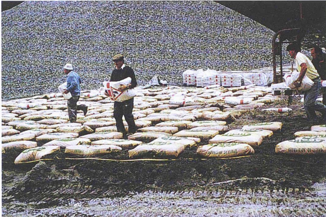
Aufbereitung der Abdichtungsmasse: Auf den Grundstoffen (Sand und Silt) werden die Tonminerale und Weisskalk sackweise verteilt, um optimale Ausgangsbedingungen zu schaffen
