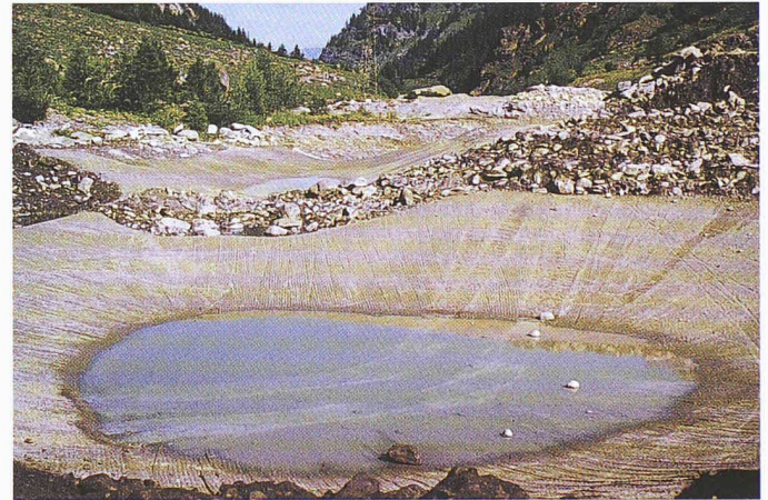
Roh gestaltete Weiherlandschaft bei Bonatchiesse. Die Sohlenabdeckung aus Kiesmaterial ist teilweise bereits eingebaut
