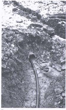
Einzug des Druckschlauches in eine alte Zementrohr- und Eternit-Wasserleitung
