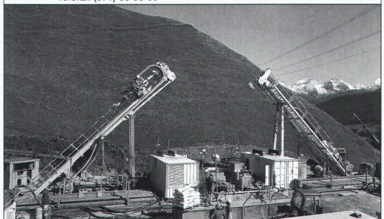
50 Baustelleneinrichtung für die Foralith-Tiefbohrungen.
