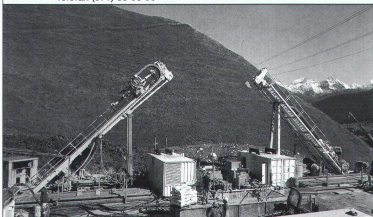
50 Baustelleneinrichtung für die Foralith-Tiefbohrungen.
