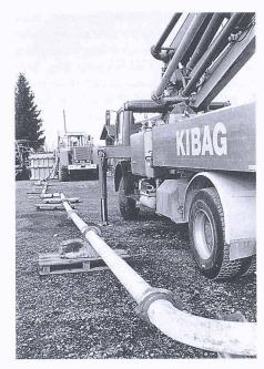
Bild 2. Pumpe und Pumpleitung
