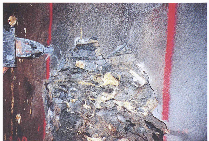
Bild 3. Das alte Tunnelgewölbe wurde in Breiten von 30 bis 50 Zentimetern aufgeschlitzt und ausgebrochen. Das alte Tunnelgewölbe und der gebräuchelte Fels dahinter wurden mit Polyurethan verfestigt.
