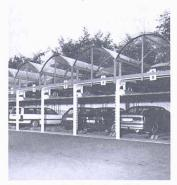
Daraus ergibt sich ein effizienteres Parken, bei geringem Flächenbedarf durch noch günstigere Raumausnutzung. Das halbautomatische Hebe- und Verschiebe-Parksystem ist rasterförmig aufgebaut, lässt sich also beliebig ausbauen. Das gewünschte Fahrzeug wird jeweils durch Nummerneingabe automatisch zum Ausparken rangiert. Dies dauert je nach Fahrzeugposition ca. 45 Sekunden.
