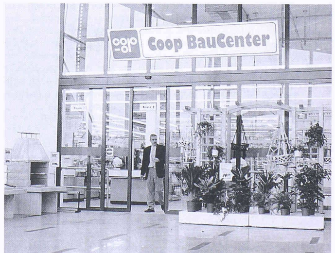
Grütpark Regensdorf: Tormax-Türautomatik, vernetzt durch LON
