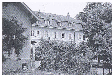
Morges, La Longeraie, Ansicht Hotelgebäude, vor dem Umbau
