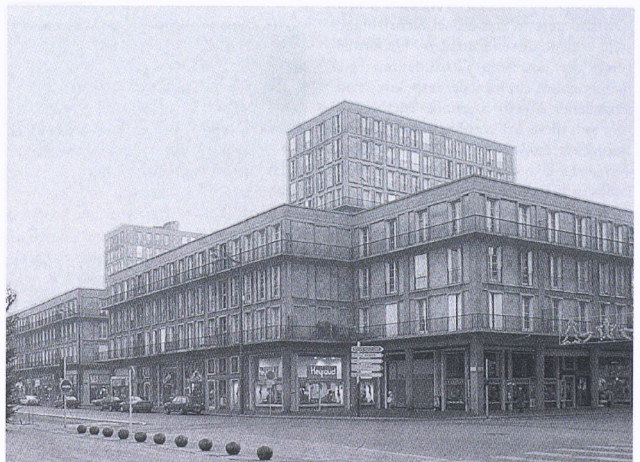
Auguste Perret: Wohnbauten am Place de l'Hôtel de Ville in Le Havre (Baubeginn 1947)
