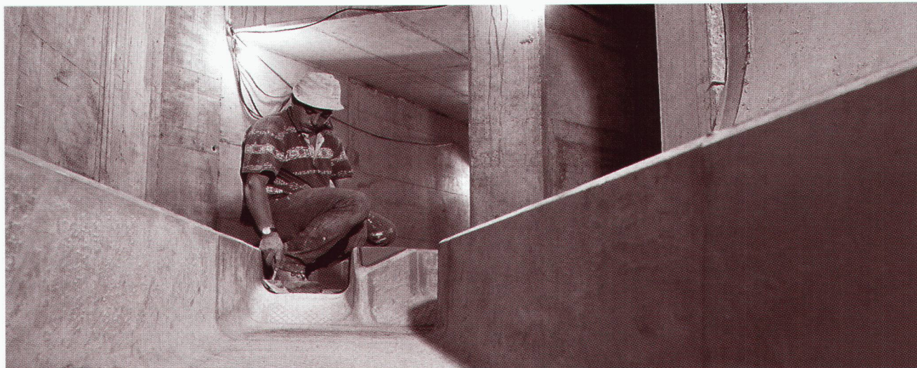
ACO-Sohlschalen, eingesetzt von der Preiswerk+Cie. AG und der Meier+Jäggi AG, Projekt: Kanalisation Zähringer-/Markgräflerstrasse in Basel
