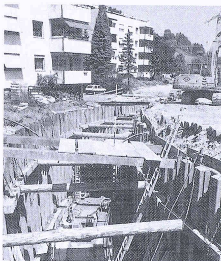
Bild 5. Ortbetonkanal, Aushubarbeiten Baugrube mit Spundwänden
