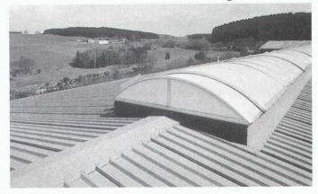
Das Hoesch isodach integral® ist das zukunftsweisende Dachsystem für anspruchsvolle Industriearchitektur und die ideale Ergänzung zur nicht sichtbar befestigten Hoesch isowand integral®. Das Hoesch isodach integral® ist ein komplettes, einbaufertiges Bausystem, das alle Anforderungen an ein Warmdach erfüllt:
