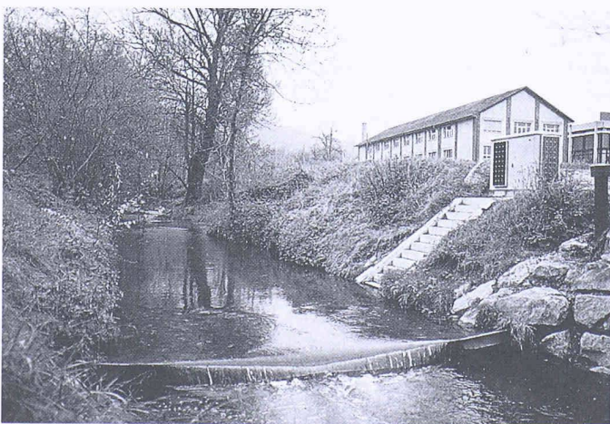
Bild 1. Die neue Messstation am Näfbach bei Neftenbach. Die Messschwelle mit der freien Überfallströmung wurde als Betonscheibe neben dem Bach erstellt und dann mit einem Kran millimetergenau versetzt. Der freie Kolk unter dem Wasserstrahl ist über 1,3 m tief und bildet einen willkommenen Lebensraum für die Fische. Die Stabilität der Schwelle und der Ufer ist durch den Blocksatz aus schweren Steinen gewährleistet. Das senkrechte Rohr neben den Steinen dient der Belüftung des Wasserstrahles. Über der Treppe mit dem schrägen Lattenpegel befindet sich der Gerätekasten mit den Sonnenkollektoren für die Mess- und Registriergeräte
