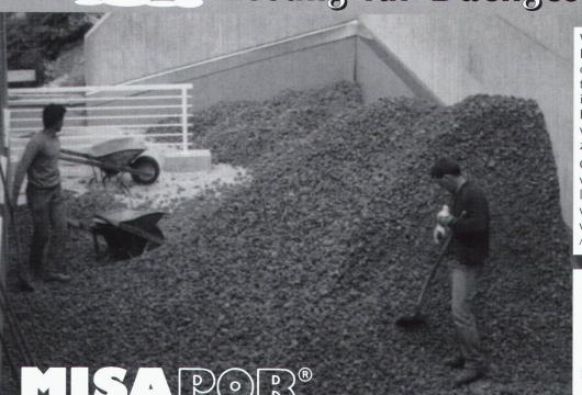
Wenn ein Dachgarten zur Landschaft werden, aber die darunterliegende Konstruktion nur minim belasten soll, ist das ein Fall für MISAPOR. Es ist Wärmedämmung, Entwässerungsebene und Wurzelraum in einem.
