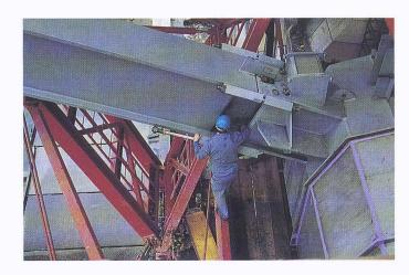
Bild 11. Provisorisches Verschrauben des Montagestosses zwischen Auflagerkonstruktion und Bogensegment (Photo L. Rentsch)
