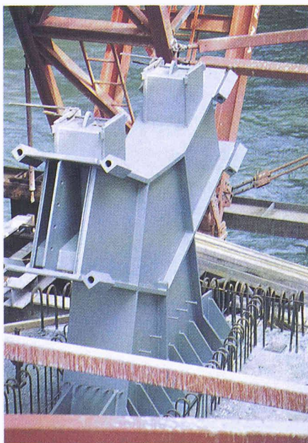
Bild 12. Bogenauflagerstück auf dem Strompfeiler (Photo L. Rentsch)
