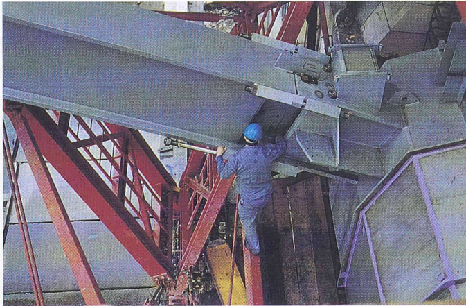
Bild 11. Provisorisches Ver- schrauben des Montagegestosses zwischen Auflager- konstruktion und Bogensegment (Photo L. Rentsch)
