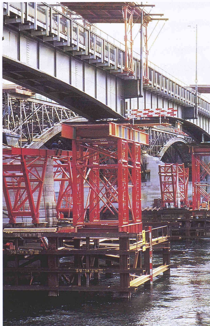
Bild 5. Montagegerüst mit Joche und Schutz gegen Schiffsanprall, Legende: 2 Montagegerüst, 5 Schutz gegen Schiffsanprall, 7 Caisson
