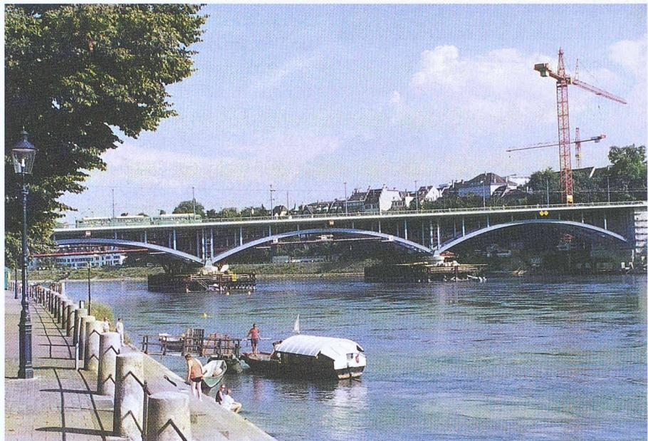
Am 1. September 1995 kann nach dreieinhalbjähriger Bauzeit die neue Wettsteinbrücke in Basel eingeweiht werden. In ihrer Grundkonzeption ähnelt sie der alten, 1877-1879 erbauten Brücke, deren Bogenfelder durch die später angefügten seitlichen Balkenträger allerdings teilweise abgedeckt waren.
